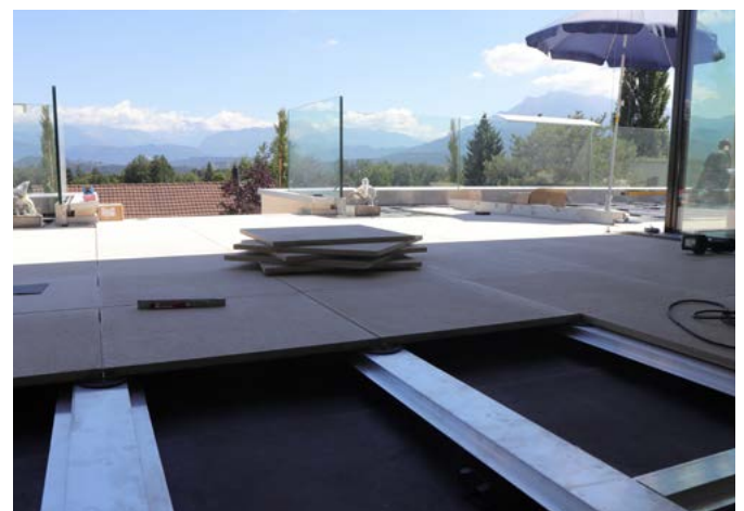
Fig. 7: Pose des dalles en céramique / grès cérame sur un système de rails.
